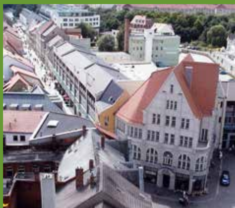
Gotthardstraße nach der Sanierung
