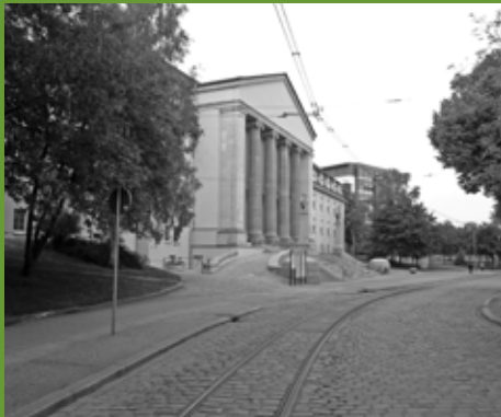
Weiße Mauer vor der Sanierung
