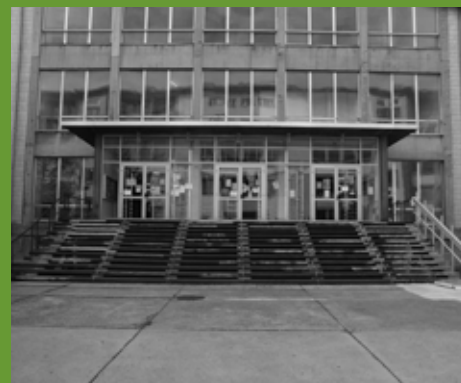
Eingangsbereich des Hauptgebäudes vor der Sanierung
