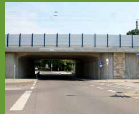
Neugestaltung der Straße, des Rad- und Gehweges unterhalb der neuen Eisenbahnbrücke
