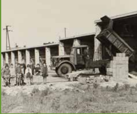
Zum Hohen Rain um 1968 - Bau der Garagen für die LPG Auenland
