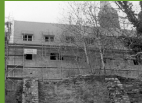
Beginn der Sanierung des Kapitelhauses im Jahr 2003
