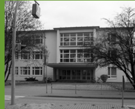
Das Hauptgebäude der Grundschule in Merseburg-Süd vor der Fassadensanierung
