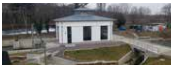
Wasserkraftwerk - Mühleninsel Merseburg
