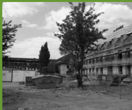
Beginn des Umbaus der Kasernen zu Wohnhäusern
