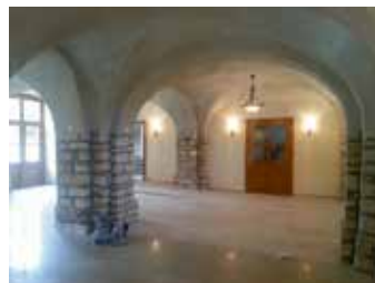
Gewölbe Haus 4 - Mühleninsel Merseburg
