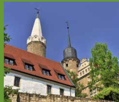
Das Kapitelhaus nach erfolgreicher Sanierung im Rahmen der Landesinitiative URBAN 21
