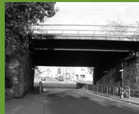
Die ehemalige Unterführung in der Teichstraße
