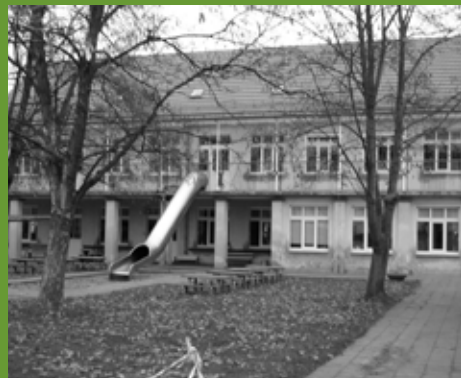
Die Kindertagesstätte Anne Frank vor der Sanierung
